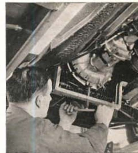
Fig. 31. — Mise en place de l'étrier de soutènement
